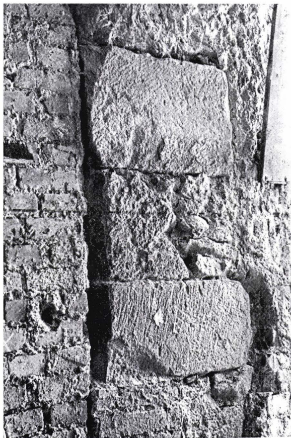
II. 13. Colț de clădire marcat cu blocuri de piatră fasonată în clădirea din Piața Sfatului 16
